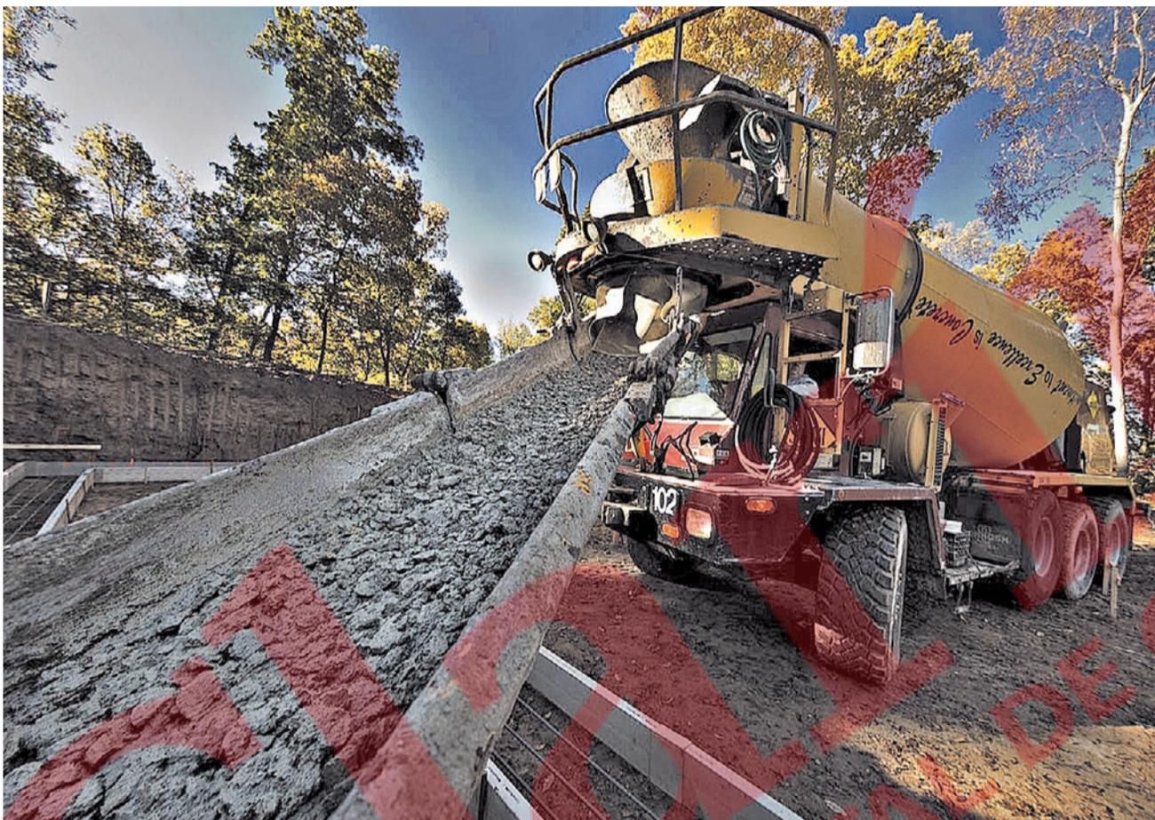
**Mixer.** La ceniza se agrega en la planta, en una proporción que ronda el 25% del peso del cemento.
