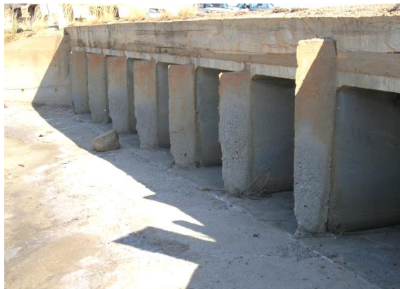
Figura 4: Ataque por acción física predominante en la zona de ascenso capilar de tabiques de alcantarillas.
