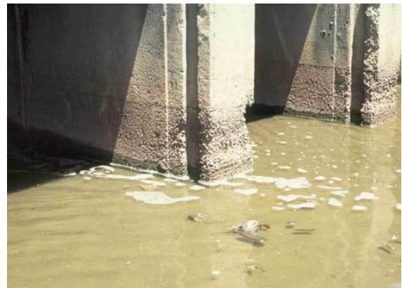
Figura 4: Ataque por acción física predominante en la zona de ascenso capilar de tabiques de alcantarillas.
