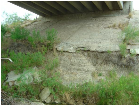
Figura 3: Estribo de hormigón desintegrado y erosionado en suelo con 1% de \text{SO}_4^{-2} , correspondiente a un ataque muy fuerte (izquierda). Detalle de fisuración y desintegración en el hormigón remanente del estribo (derecha).
