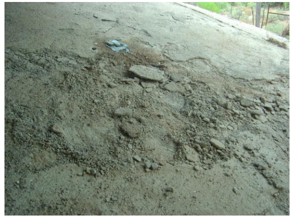
Figura 3: Estribo de hormigón desintegrado y erosionado en suelo con 1% de \text{SO}_4^{-2} , correspondiente a un ataque muy fuerte (izquierda). Detalle de fisuración y desintegración en el hormigón remanente del estribo (derecha).
